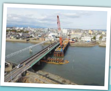
平成30年6月、仮橋の架設に着手 (写真:平成31年2月)
