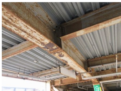
アスト駐車場 支柱
