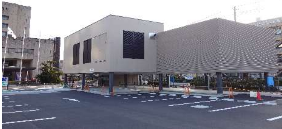
受変電設備 (キュービクル棟)
