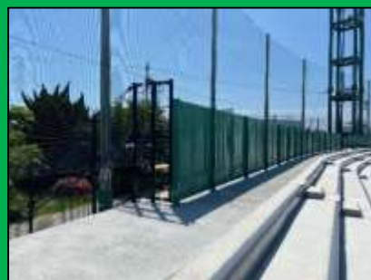
フェンス改修
