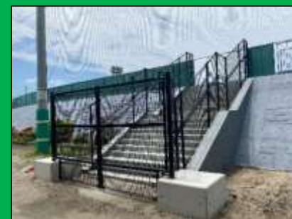
スタンド入口改修
