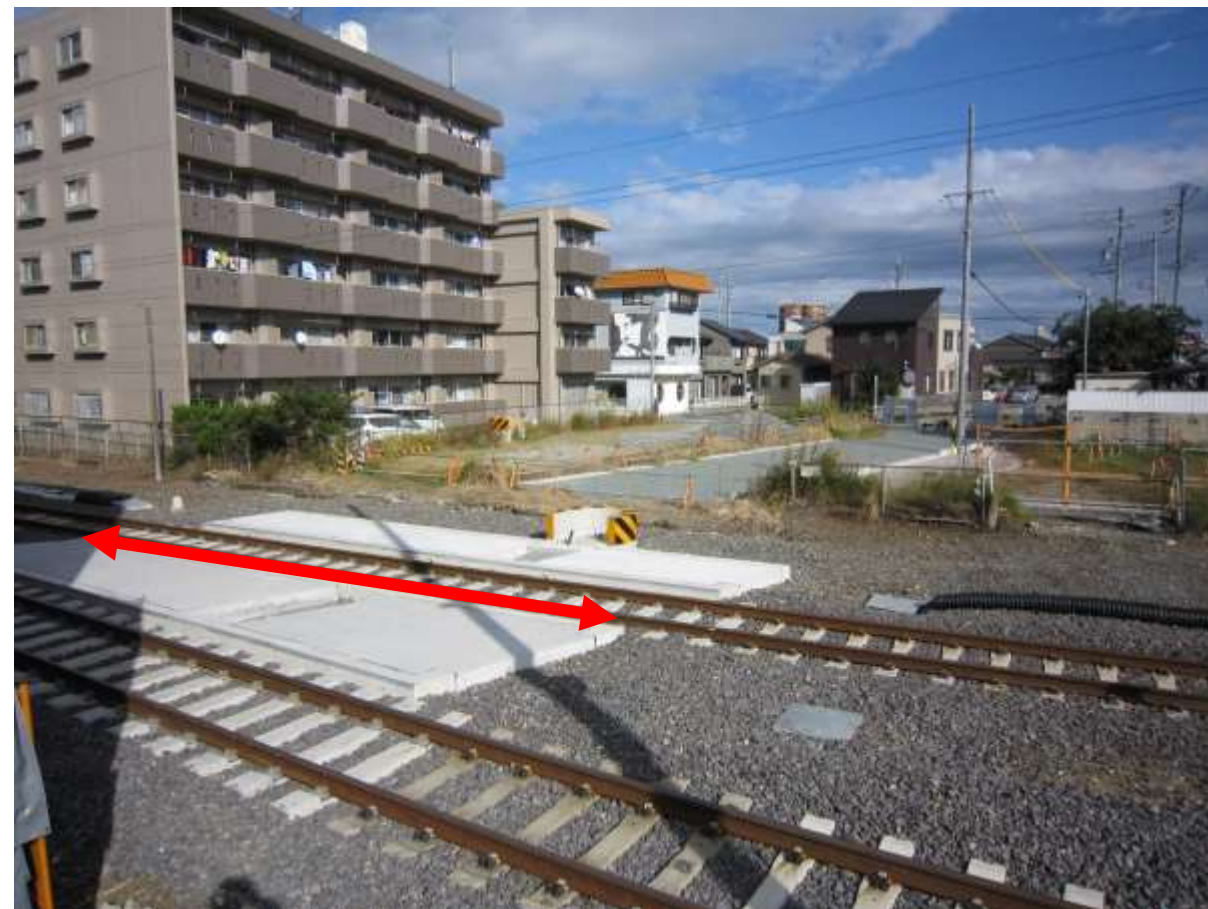
新踏切工事中
