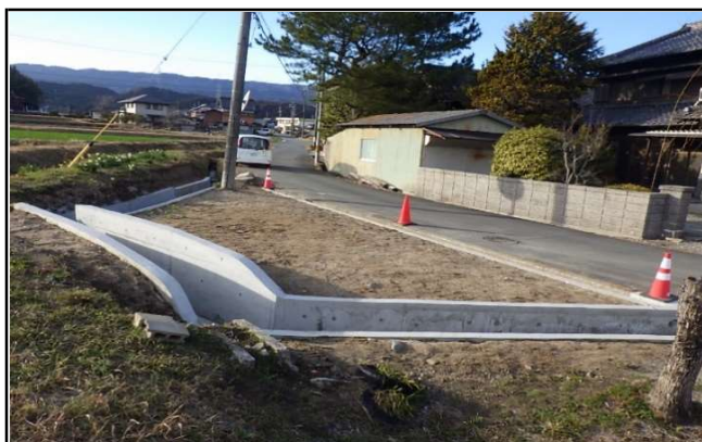
3 物件南東部から北西を望む
