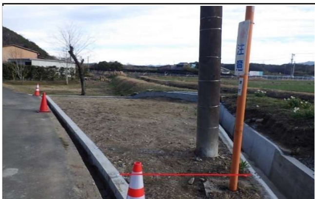
1 占有物（電柱）の状況
