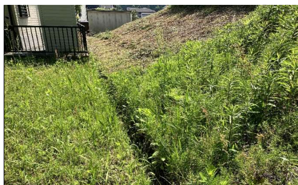
8 敷地奥の状況
