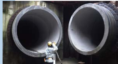
半田川田雨水幹線築造工事の様子
