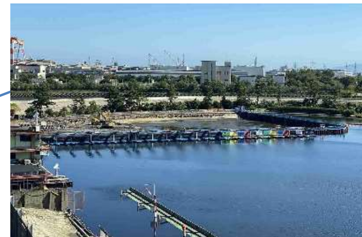
地盤改良工事
