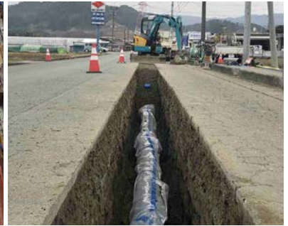
配水管布設工事の様子
