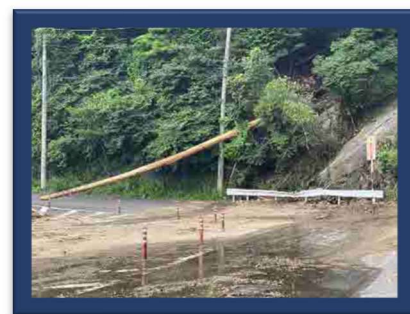
▲甚濃の土砂崩れの様子
