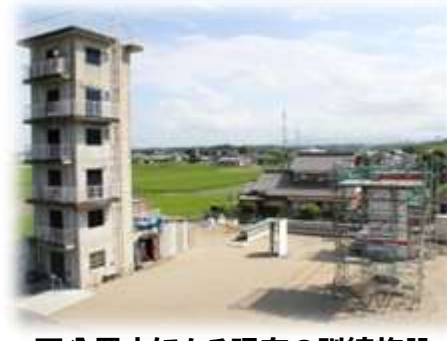
西分署内にある現在の訓練施設
