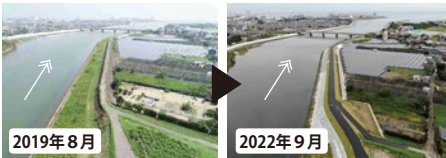
雲出古川の堤防整備
