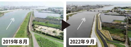
雲出古川の堤防整備
