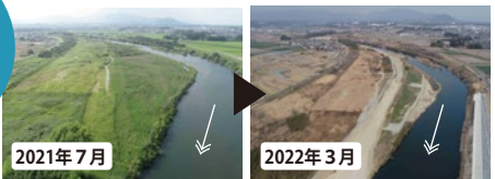
雲出川の河道掘削
