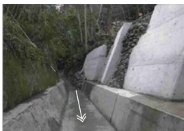
王子討谷川の護岸整備
