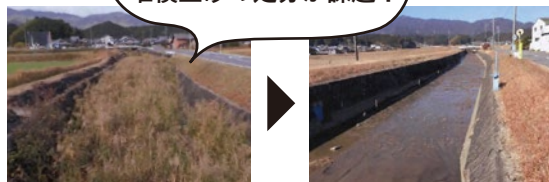
堆積土砂の撤去前・撤去後(準用河川大谷川)
