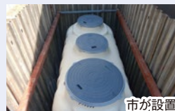
市が設置した浄化槽
