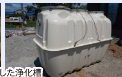
市が設置した浄化槽
