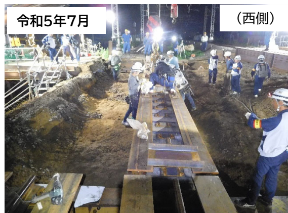
近鉄架道橋 仮桁設置作業
