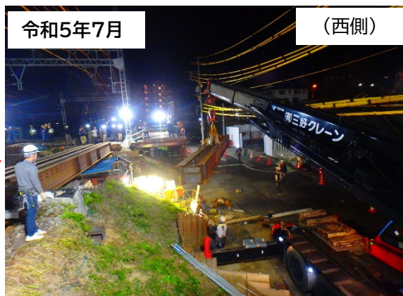
近鉄架道橋 仮桁設置作業
