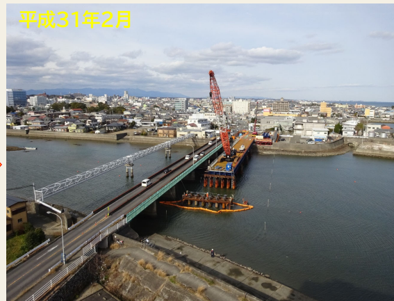
迂回路仮橋・工事用仮橋設置作業
