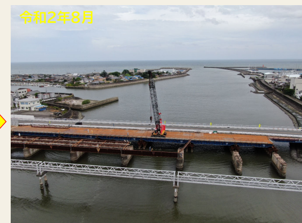
既設上部工撤去作業中
