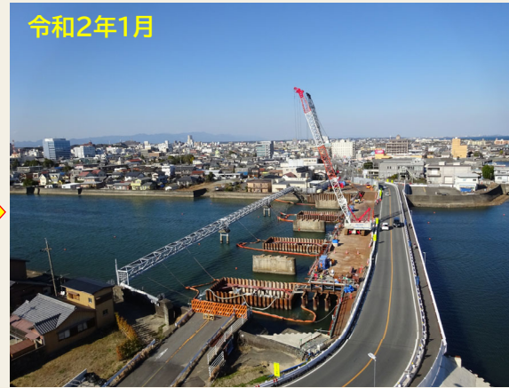
既設橋脚締切作業
