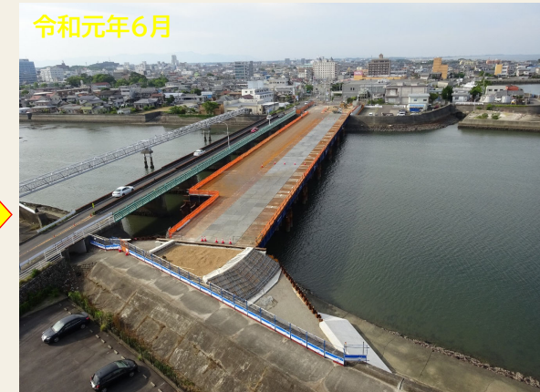
迂回路仮橋・工事用仮橋設置作業
