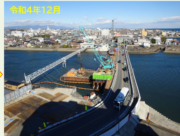
新橋脚 場所打ち杭作業
