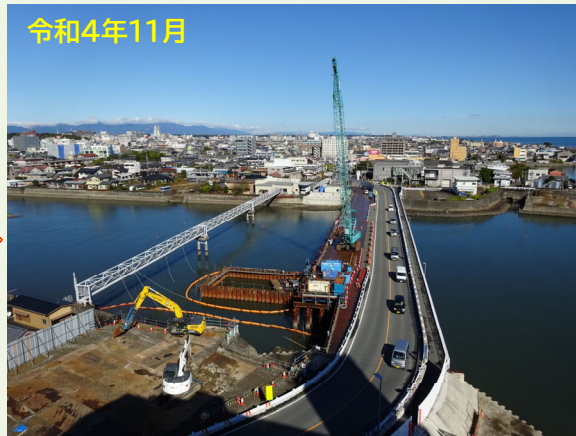
河川内締切作業
