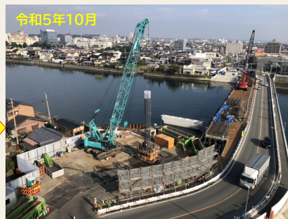
新橋台 場所打ち杭作業
