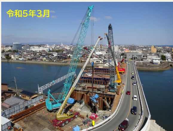
河川内二重締切作業
