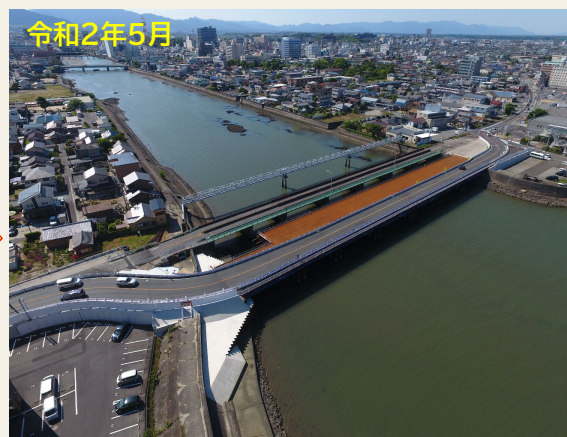
迂回路仮橋・工事用仮橋工事完了
