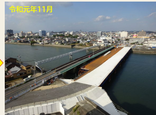
迂回路仮橋・工事用仮橋設置作業
