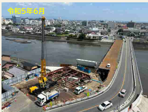
旧橋台 撤去作業
