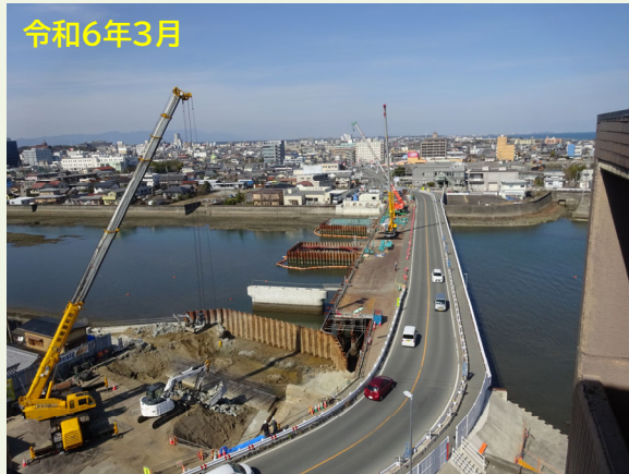
新橋台、橋脚の構築及び護岸復旧
