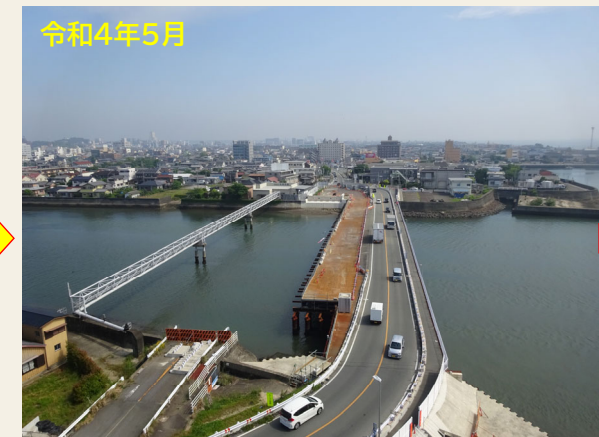
既設橋脚撤去完了
