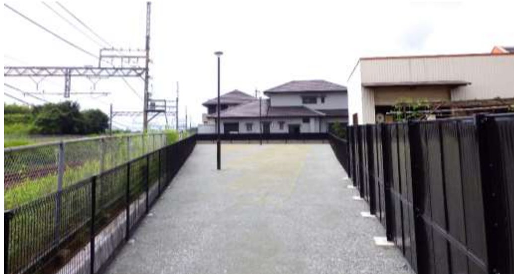
北側から見た全景
