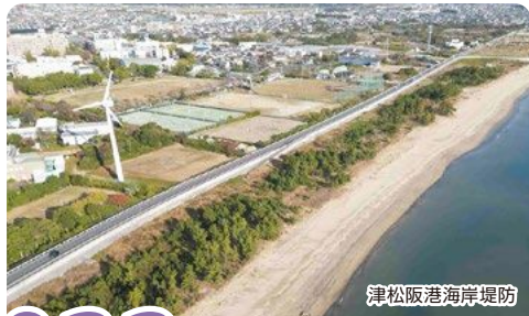
津松阪港海岸堤防
