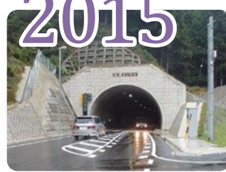
県道一志美杉線矢頭トンネル
