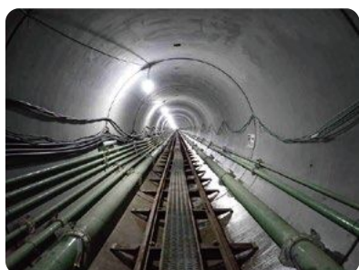
管径2.2mの雨水管の内部
