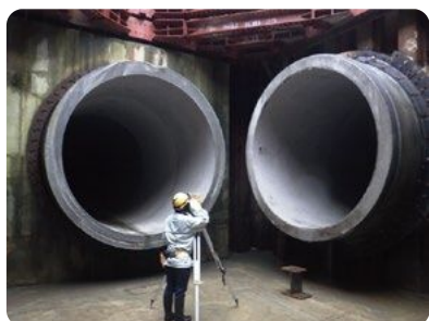
管径2.8mと2.6mの雨水管の合流箇所
