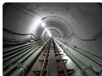
管径2.2mの雨水管の内部
