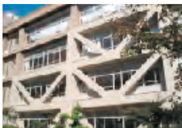
耐震改修の完了した校舎
