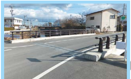
④上野東千里線(瓶冠橋)道路改良
