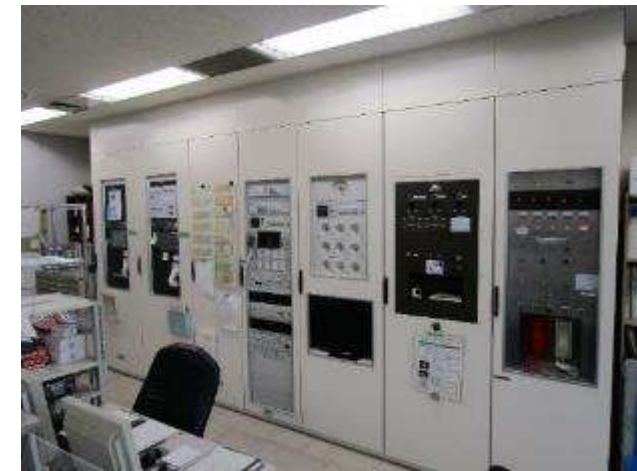
中央監視装置 (地階から本庁舎3階へ)
