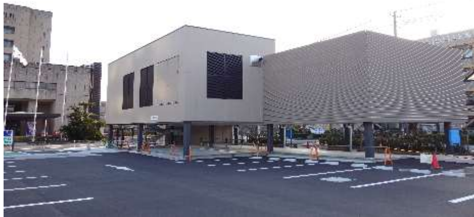
受変電設備 (キュービクル棟)
