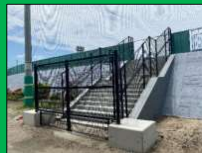
スタンド入口改修
