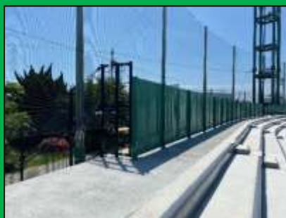
フェンス改修
