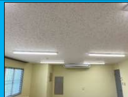
諸室照明LED化
